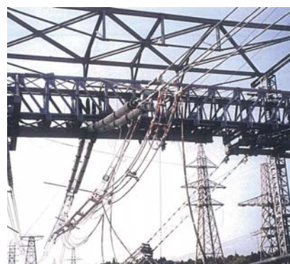
■パイプジャンパ装置 横振れ試験
